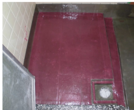
アquaUVシートNS張付状況
