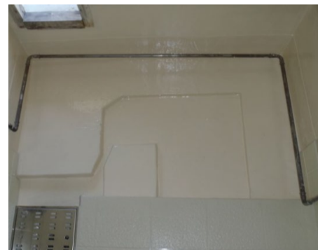
浴室防水工事完了後
